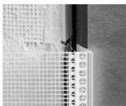
Anschluss des zweiten Profils
