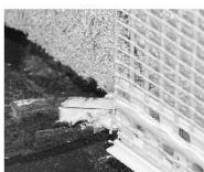
Justieren des Fugenflankenprofil-Verbinders
