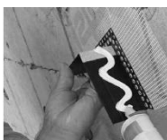
StoColl Fix auftragen
