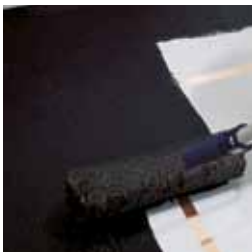
A vezetőréteg koromtartalmú, vizes epoxi gyanta diszperzió
