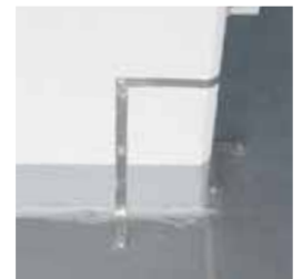
A földelőkészlettel létrehozott földelési csatlakozás
