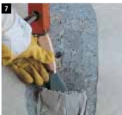
7 Lezáró réteg eltávolítása
