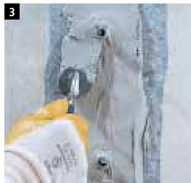
3 Repedés lezárása
