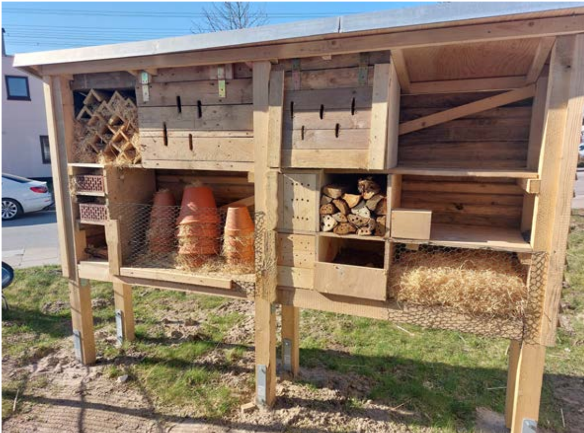
Auszubildende aus fünf Verkaufszentren im Norden Deutschlands haben ein begrüntes Insektenhotel auf dem Gelände in Hamburg-Oststeinbek gebaut. Foto: Sto SE & Co. KGaA
