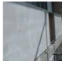
Helyreállított mellvéd (felületképzés nélkül)
