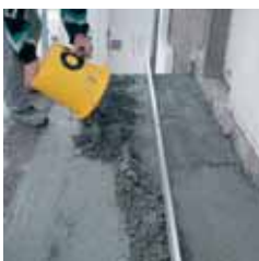
A PCC esztrich felhordása a friss tapadóhídra (nedves a nedvesre)
