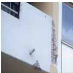
Károsodott balkonmellvéd
