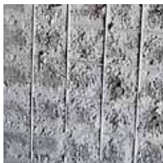
Előkészített balkonmellvéd alapfelület
